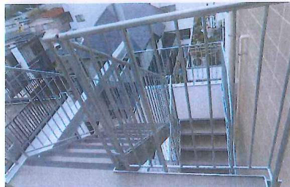
避難用外非常階段
